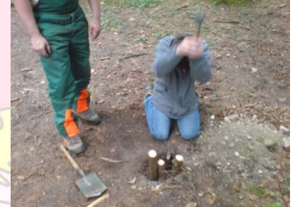
Abb.: 13 "Fundament" Erstellung
